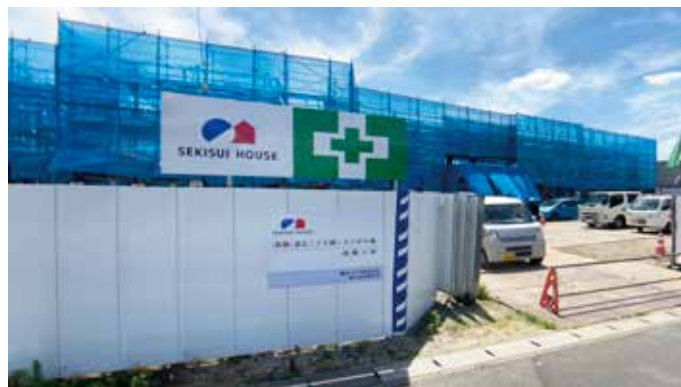
威風堂々の新園舎建設現場
